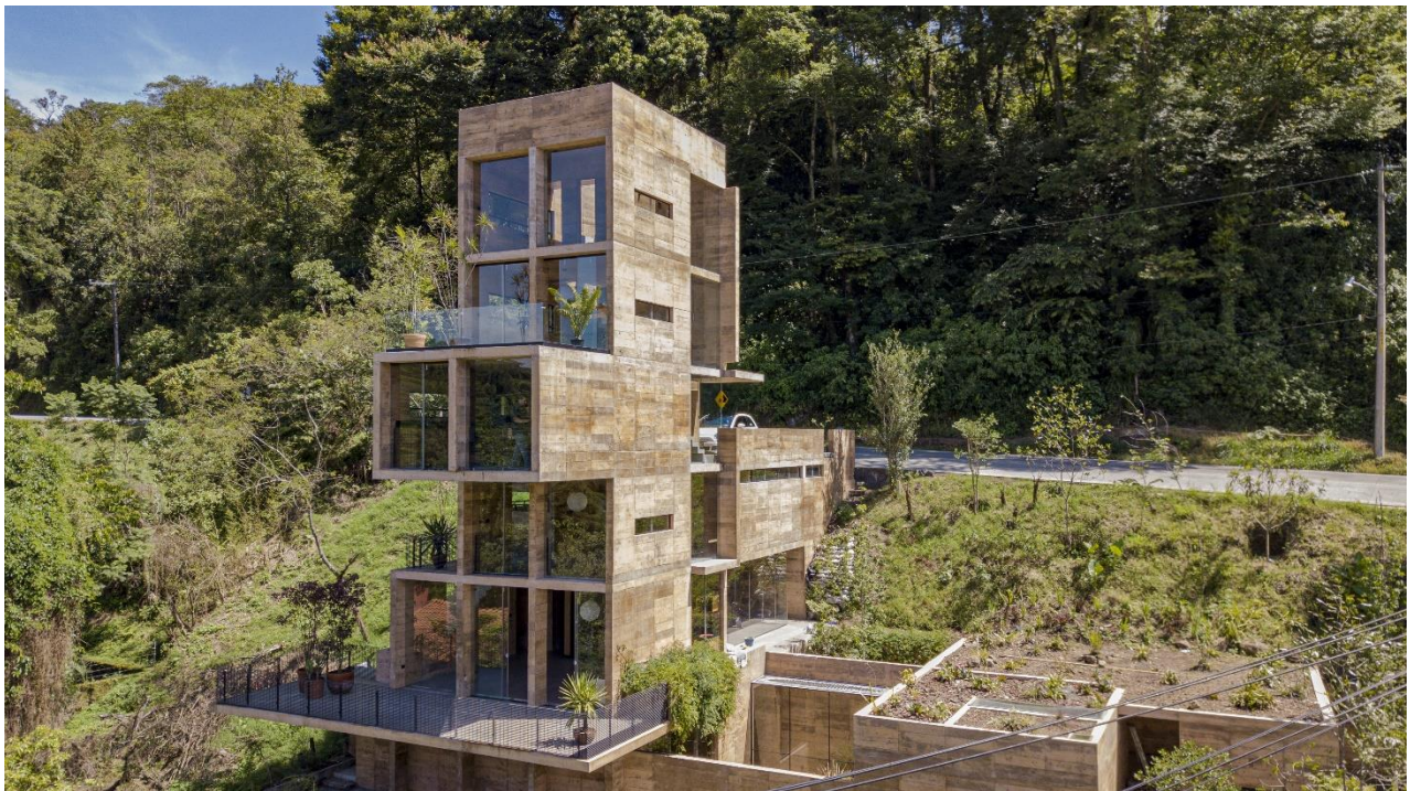
Departamentos Zoncuantla, Veracruz, México Construido con Hidratium, parte de nuestra familia de productos sostenibles Vertua
